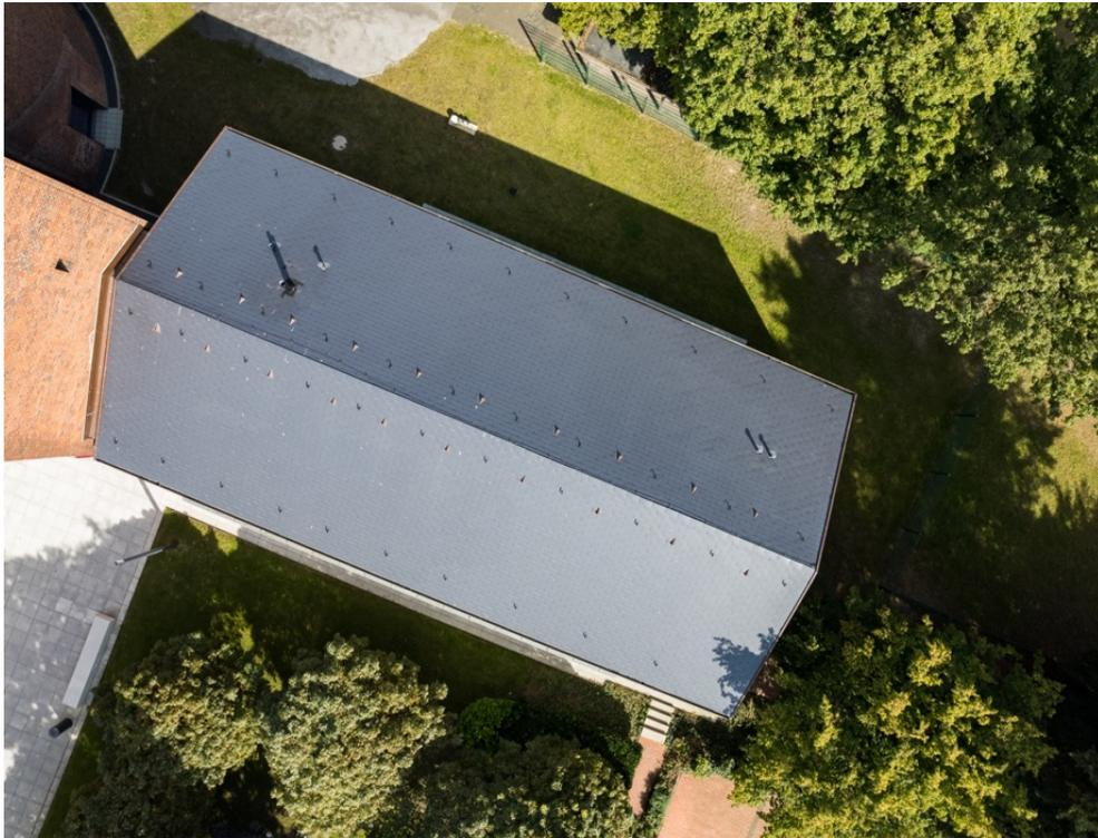
Faserzementplatten ermöglichen eine besonders flache Eindeckung und stehen für eine moderne, klare Dachgestaltung.
