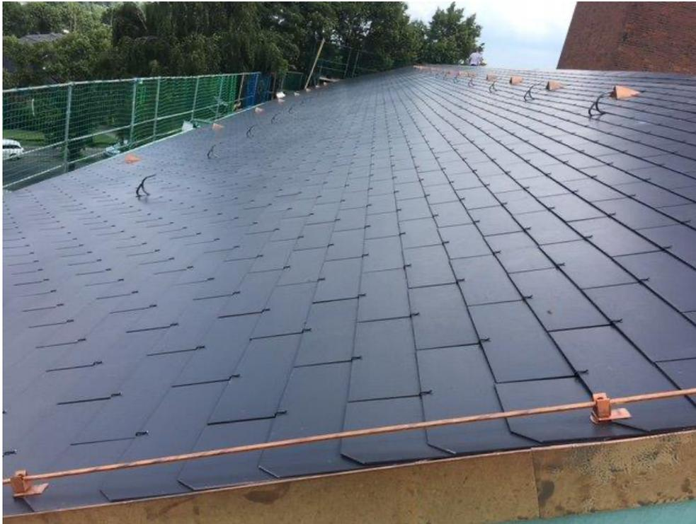
Die Dachfläche in Doppeldeckung punktet mit einem hohem Witterungsschutz und besonderer Langlebigkeit. Außerdem müssen Eindeckungen mit glatten Faserzementplatten kaum gewartet werden.
